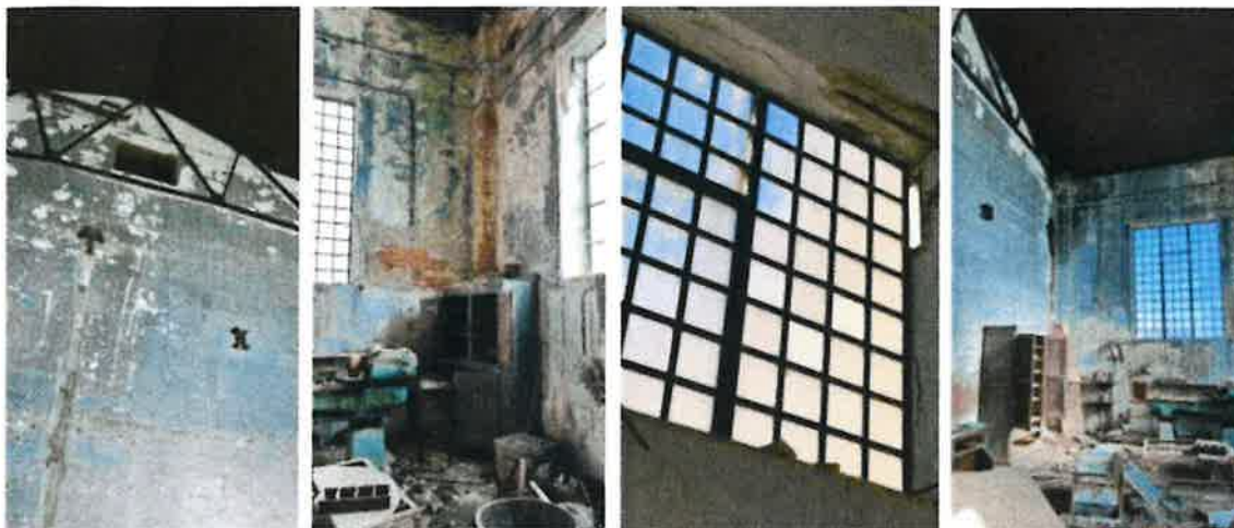
Figura 9 - Levantamento do edifício existente para elaboração do relatório de avaliação energética
