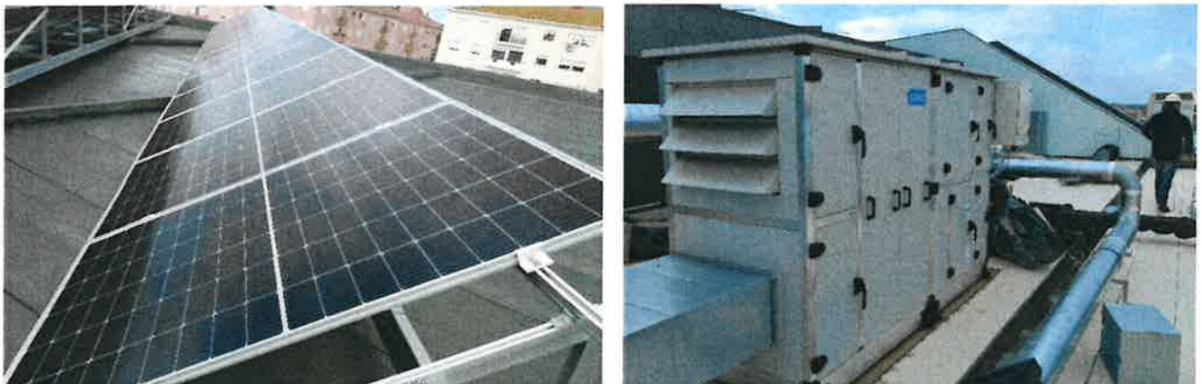
Figura 12 - Desenvolvimento de obra
